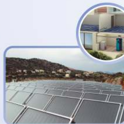
Τοποθέτηση στο έδαφος
