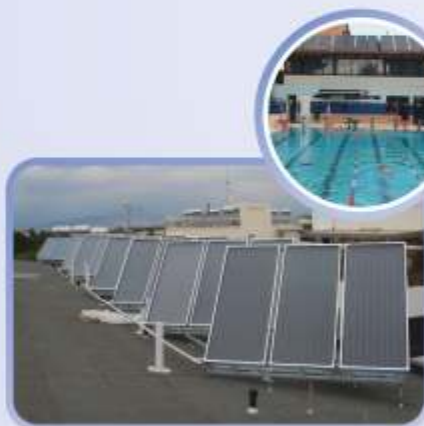
Τοποθέτηση πάνω σε οροφή
